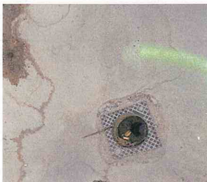
Piézomètre NPZ9 non protégé avec présence de boue.
