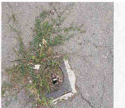
Ouvrage PIII Absence de capot, présence de végétaux
