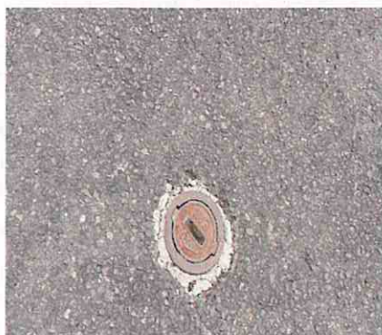
Ouvrage PZ1 Présence d'un capot mais ce dernier n'est pas sécurisé.
