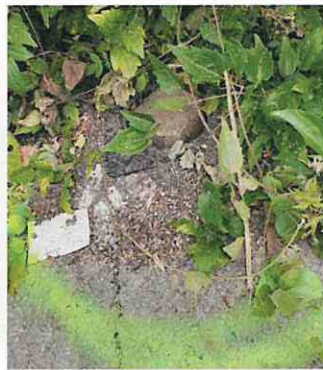
Ouvrage PZA absence de capot, recouvert d'une pierre et enfoui sous les végétaux
