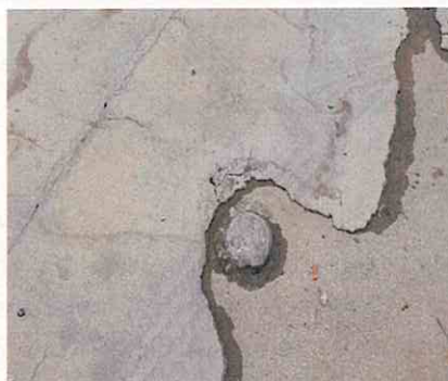
Piézomètre PZ9 comblé en 2016 Le béton ne recouvre pas la totalité du capot
